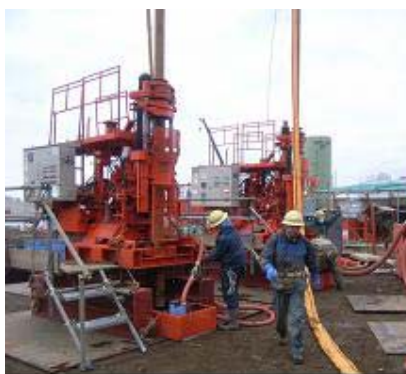
浄化工事実施状況
