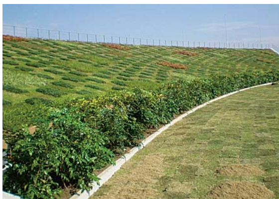
施工完成写真 1
