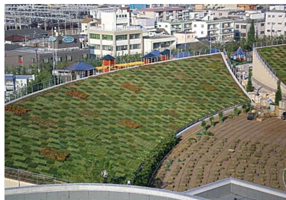
施工完成写真 2
