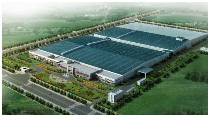
杭州横浜輪胎のタイヤ工場図。右奥が第4期拡張の区域
