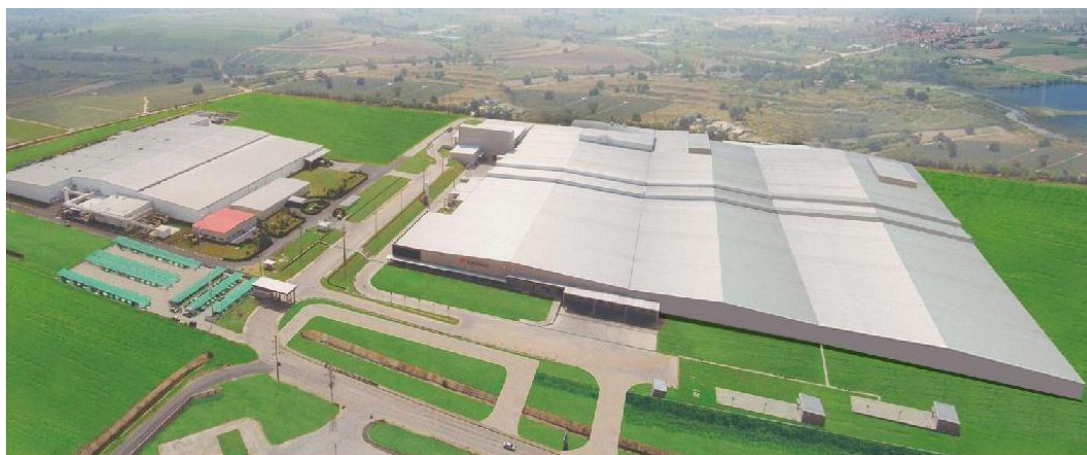
パース図右側建屋が第3次拡張後のPC/LTタイヤ工場
