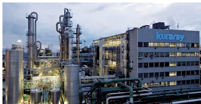
KEGのポバール生産設備外観
