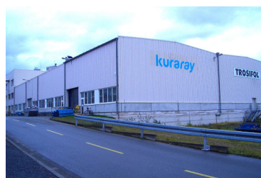
KEG(トロイスドルフ)のPVBフィルム生産設備外観
