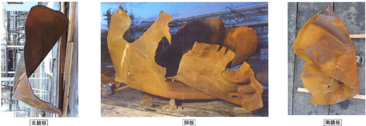
図-8 塩酸塔還流槽の破壊状況
