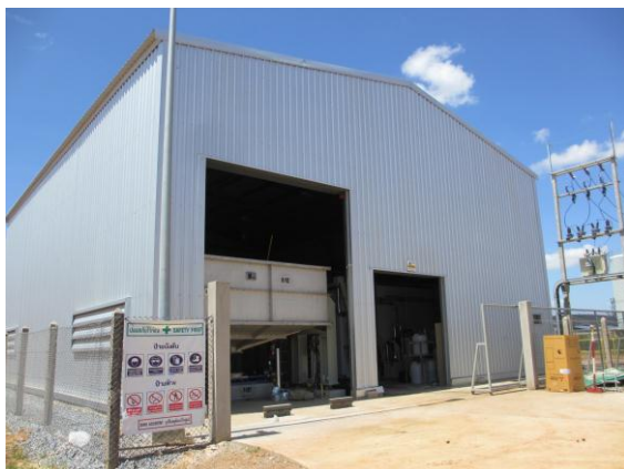
パイロットプラント建屋
