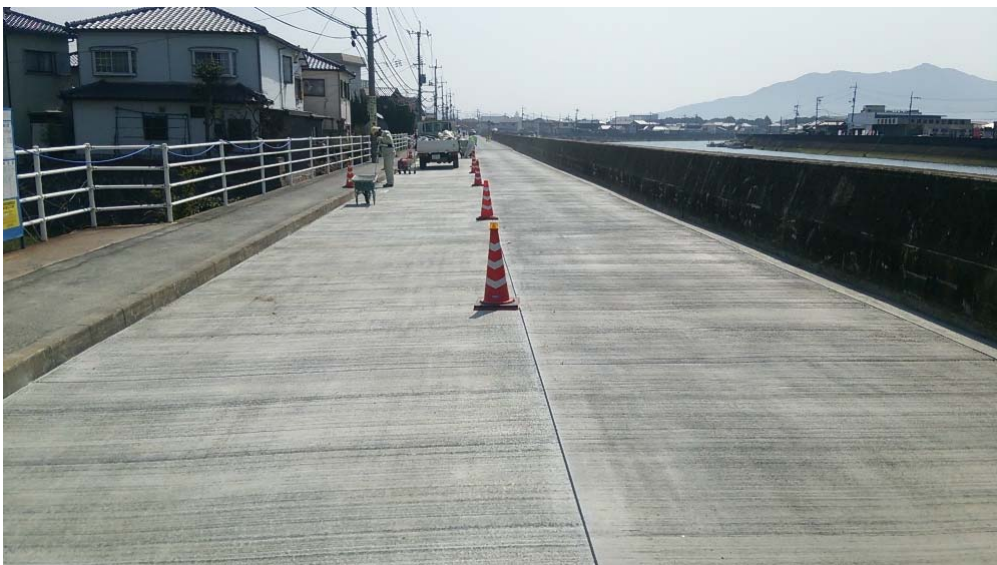
コンクリート打設完了後
