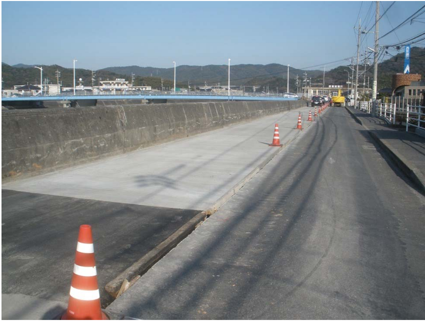
アスファルト舗装撤去後
