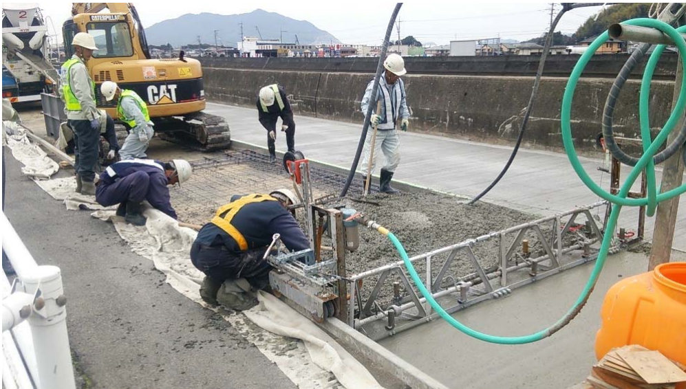
コンクリート打設
