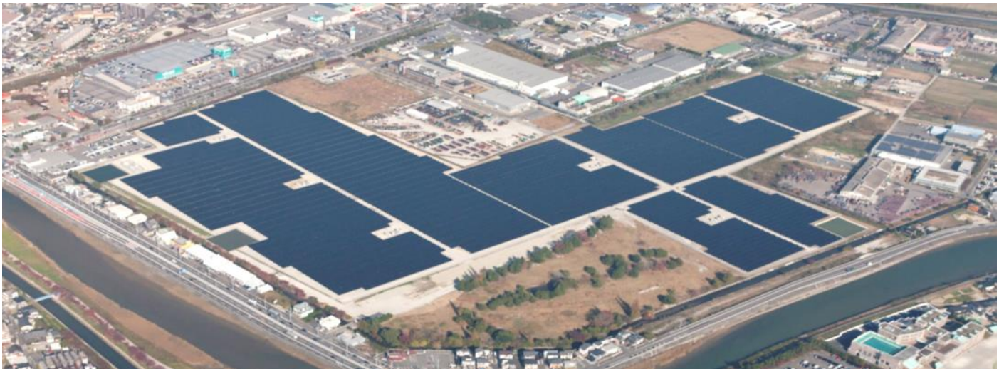
日本太陽光発電 2013 合同会社殿向け 半田ソーラー発電所 (愛知県半田市:19.6MW) 航空写真
