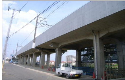
鉄道高架橋高欄の補修例
