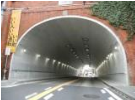
トンネルの補修例
