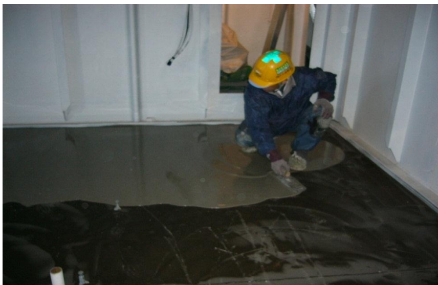
【U/D シップレベラーの施工】
