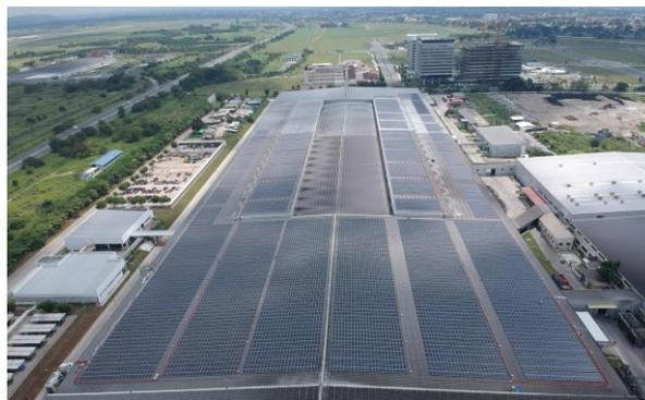
ヨコハマタイヤフィリピンの生産工場の屋根に設置した太陽光発電システム
