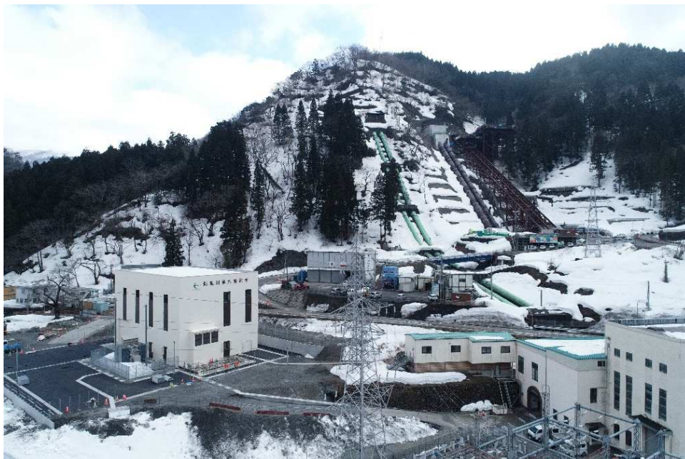
<新姫川第六発電所 全景>
