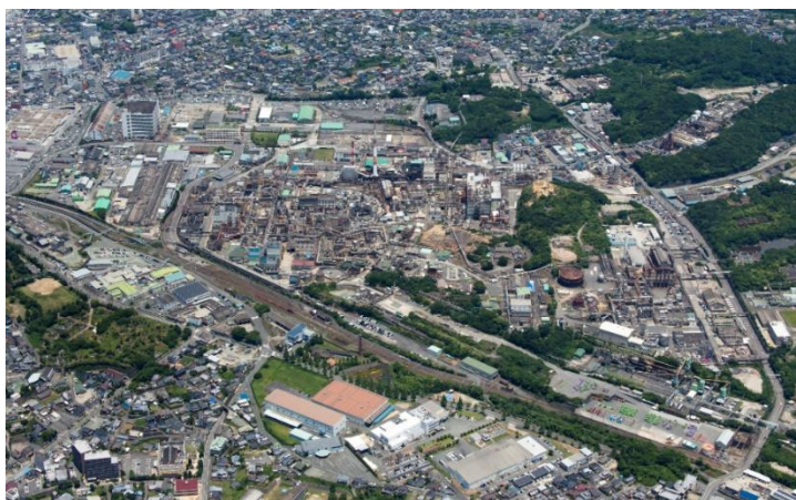
三井化学 大牟田工場全景
