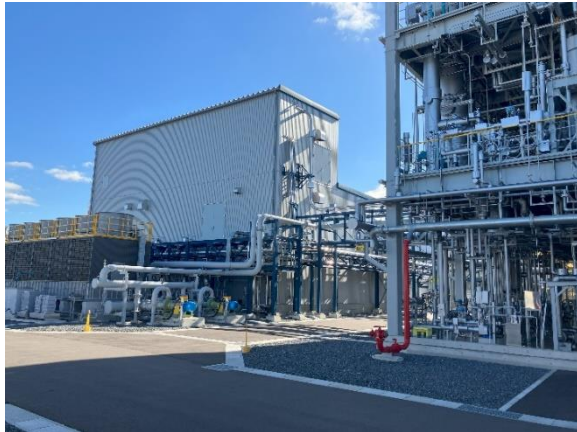
2024年3月に本格稼働予定のシュガーエステル製造設備（2,000 トン/年） 2026年3月に新ライン 1,100 トン/年をさらに追加予定（三菱ケミカル九州事業所）
