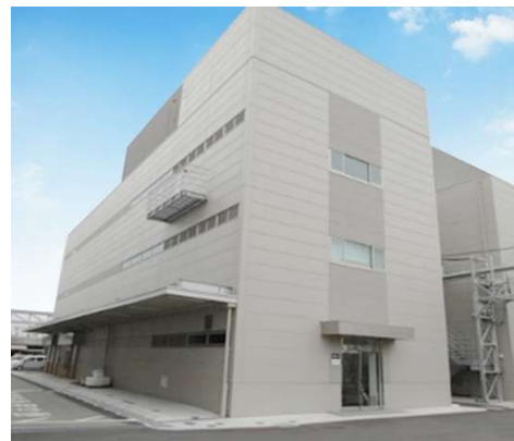
富士フィルム和光純薬の大阪工場： 今回生産設備を増強した医薬品製造用原料の生産棟
