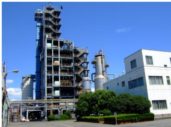
川崎プラスチックリサイクル（KPR）プラント
