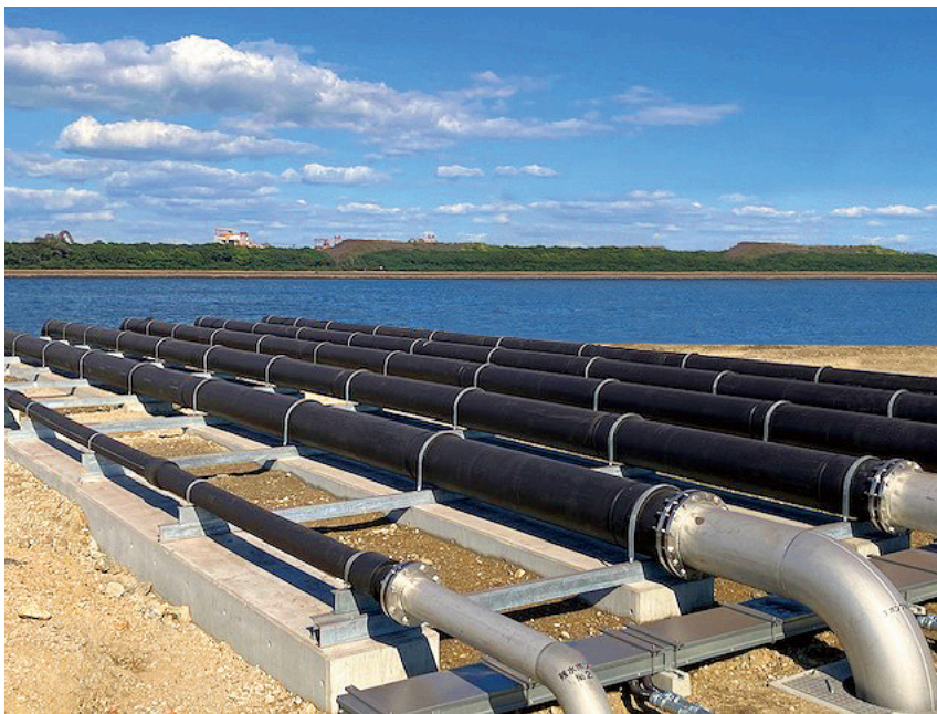
「プラントハイパーBK」の施工事例
